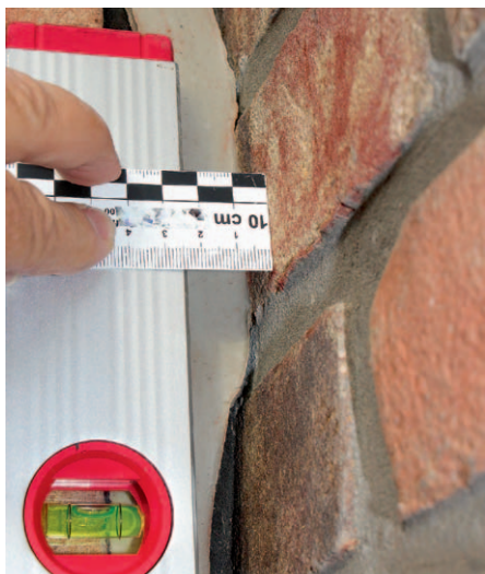
(2) Terrassenseitige Fuge zwischen Wohnhaus und Garage
