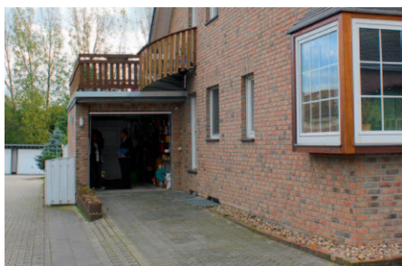
(1) Straßenansicht der Garage und des Wohnhauses
